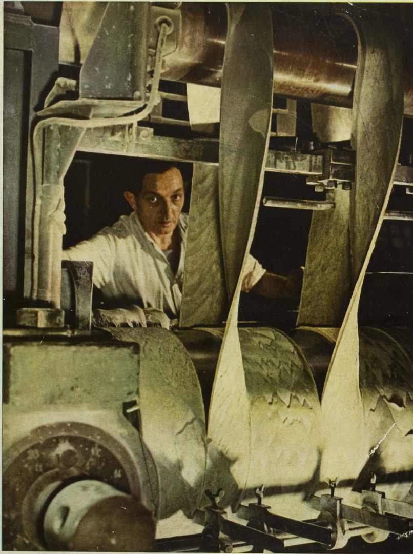
Stabilimento Pirelli di Bicocca Mescolatore a cilindri per la lavorazione delle mescole di gomma
