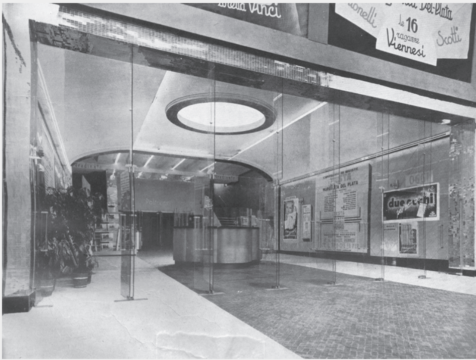
V.I.S. (Vetro Italiano Sicurezza). Grande vetrata in cristallo Securit (9,50 x 5,00 mt) per l'ingresso al Cinema-Teatro Universale di Genova. Ideata e realizzata dalla Soc. An. V.I.S. "V.I.S. Ingresso al Cinema-Teatro Universale di Genova" (1940, maggio). Domus , 152, 103.
